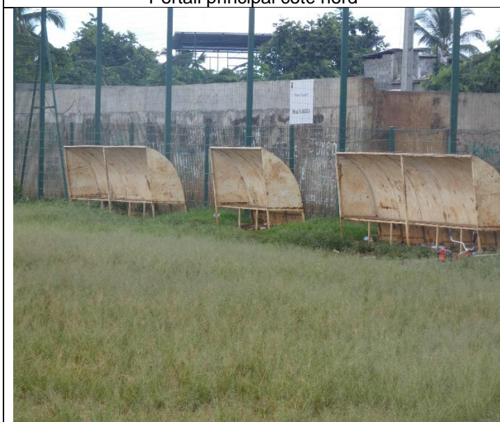
Bancs de touche existants
