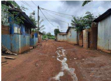
Le projet vise à éradiquer le logement insalubre de ce village de la commune de Ouangani.
